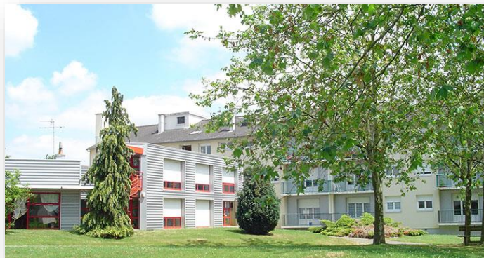
Résidence Le Pont Aux Moines Saint Gilles
