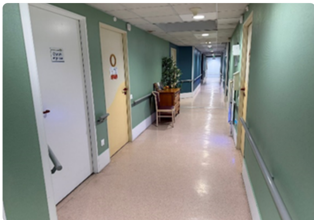
Réfection du couloir de la Résidence du Pressoir
